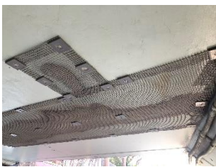
秋津地区側出口付近天井
