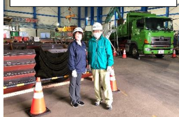
鷺沼放流幹線工事現場視察
